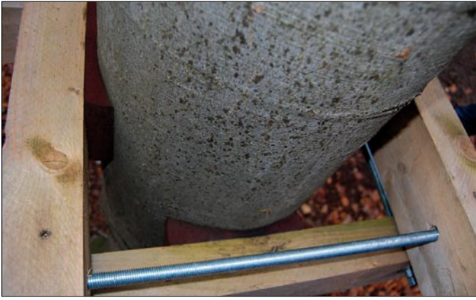
Abb. 3: PU-Formstücke zwischen Balkenlage und Baumrinde zur Reduzierung des Anpressdruckes.
