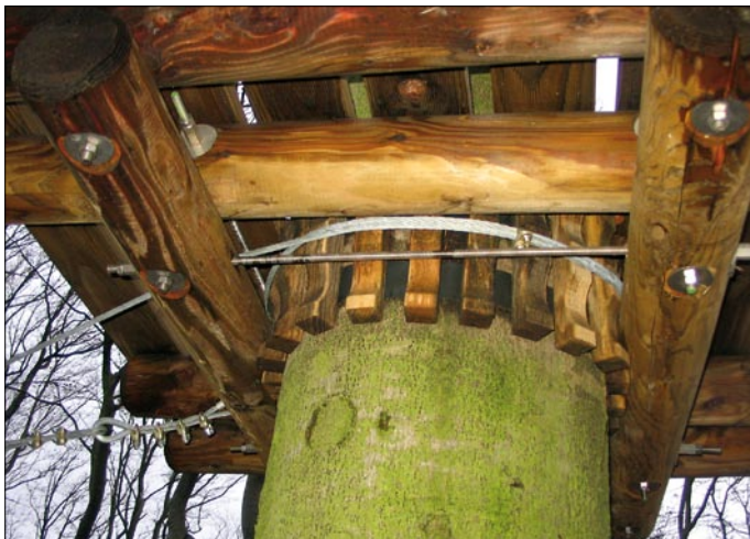
Abb. 5: Befestigung einer Plattform sowie eines umschlingenden Stahlseils in einer Belastungsebene
